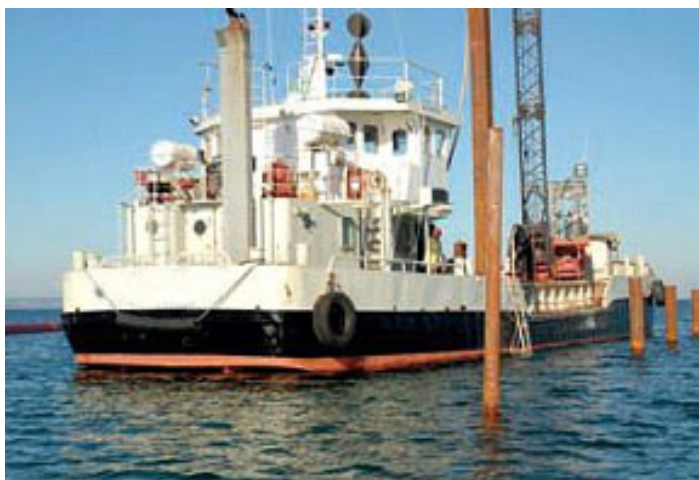
Fig. 5.10 Utläggning av pålar.
