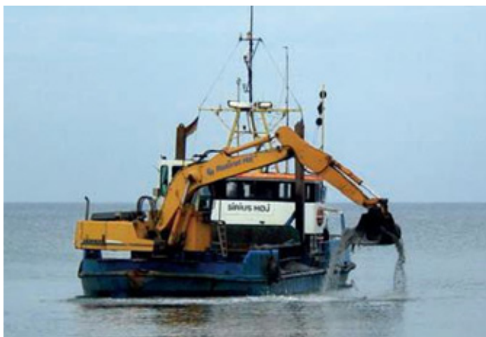
Fig. 5.5 Ett dike grävs ut under vattnet av ett mudderverk.
