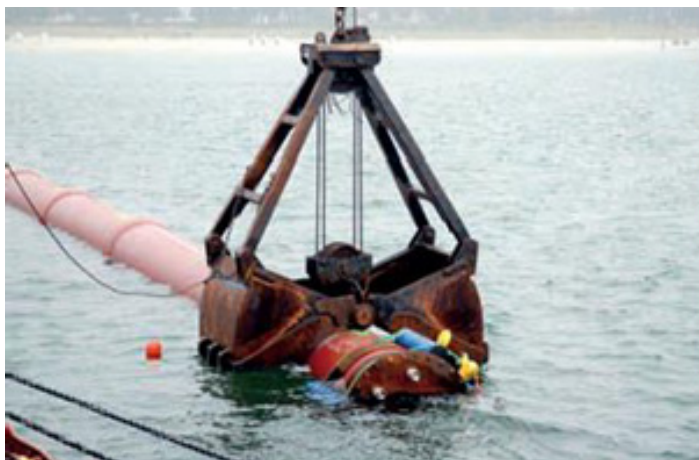
Fig. 5.7 Draghuvud med påfyllningsventiler.
