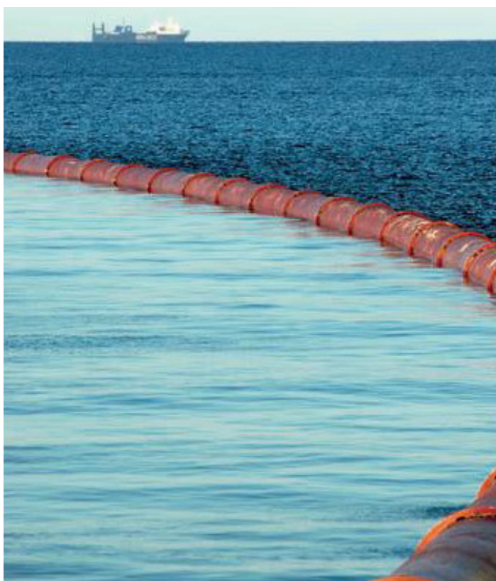
Fig. 5.11 och 5.12 Flottningen av en segjärnsledning och dess avvinkling orsakad av strömmarna.
