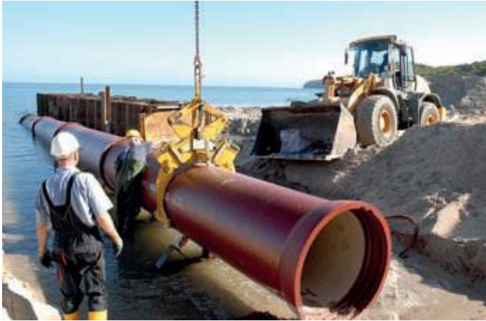
Fig. 5.3 Rör-för-rör montering.
