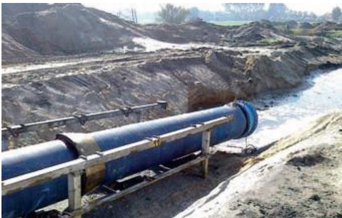
Fig. 5.4 Ledningsmontering sektionvis.
