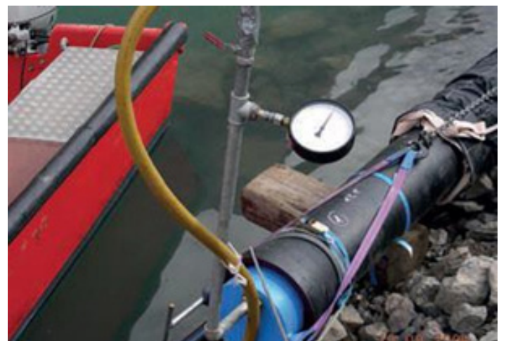
Fig. 5.6 Provtryckning av en DN 200 ledning.
